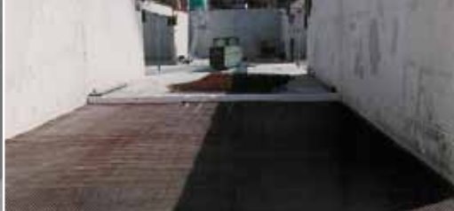
Замена бетонной подготовки под фундаментной плитой.
