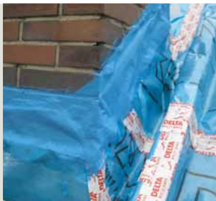
Примыкание к трубе DELTA®-LIQUIXX
