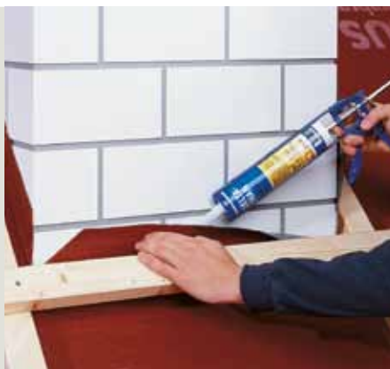
Примыкание к трубе DELTA®-THAN
