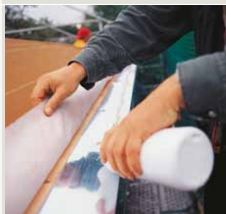
Проклейка на карнизном свесе DELTA®-PREN
