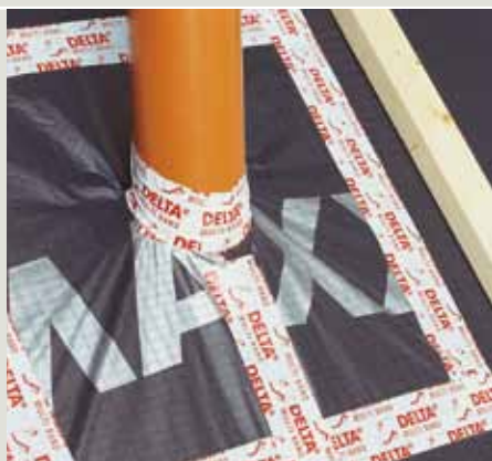
Уплотнение проходки DELTA®-MULTI-BAND
