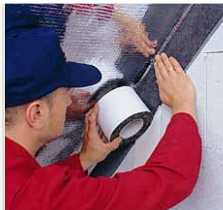
Примыкание к стене DELTA®-FLEXX BAND
